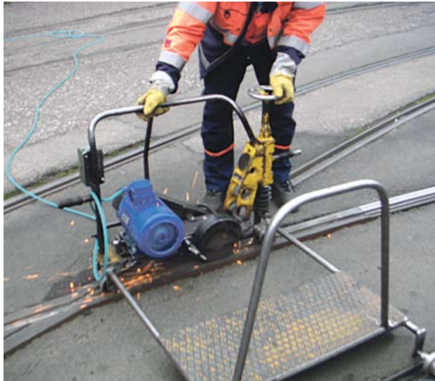
Na probi brušenja u remizi Trešnjevka uočena su daljnja poboljšanja...
